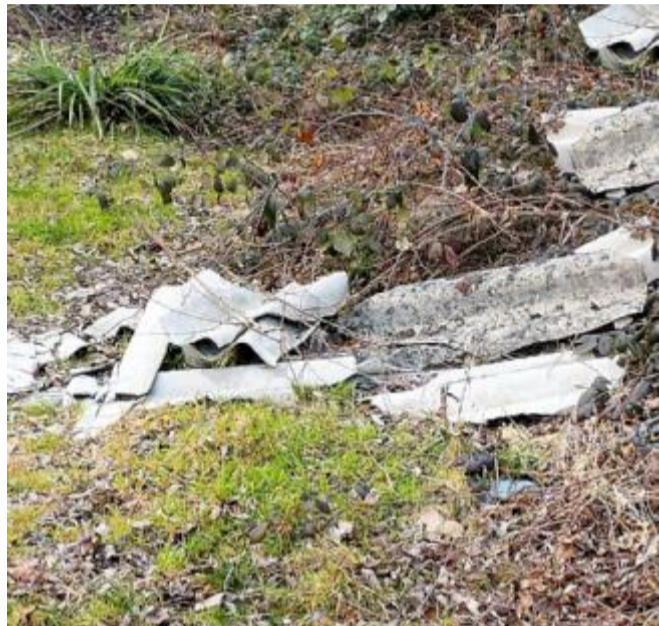
Parte dei resti di eternit trovati nella zona del bosco di Novoledo. G.A.R.
